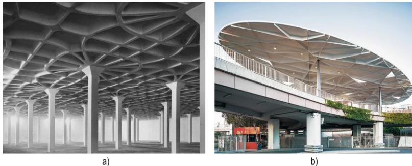
Bild 2 a) Wollfabrik Gatti, Rom von Pierre Luigi Nervi, 1951-1953. Quelle: (4); b) Überdachung Messe Frankfurt – Tor Nord, Ingo Schrader Architekt, Bollinger + Grohmann Ingenieure. Quelle: (6)
